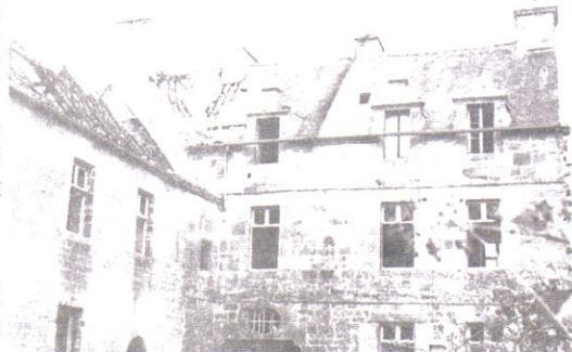
Le manoir du Tromeur, en Bohars, propriété de la famille Huon de Kermadec, après incendie et avant sa démolition.
