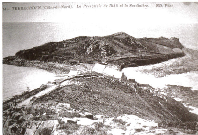
Conserverie de la Pointe de Bihit à Trébeurden
