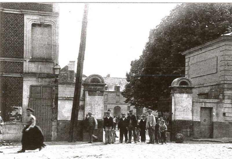
Ourscamp : la sortie des ouvriers
