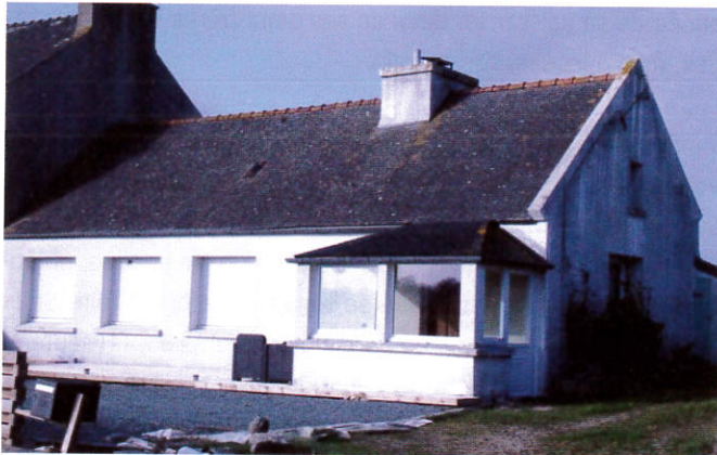
Tréguerné en Saint-Derrien, état actuel. La maison a perdu depuis longtemps son toit de chaume. Photo Jean François Pellan
