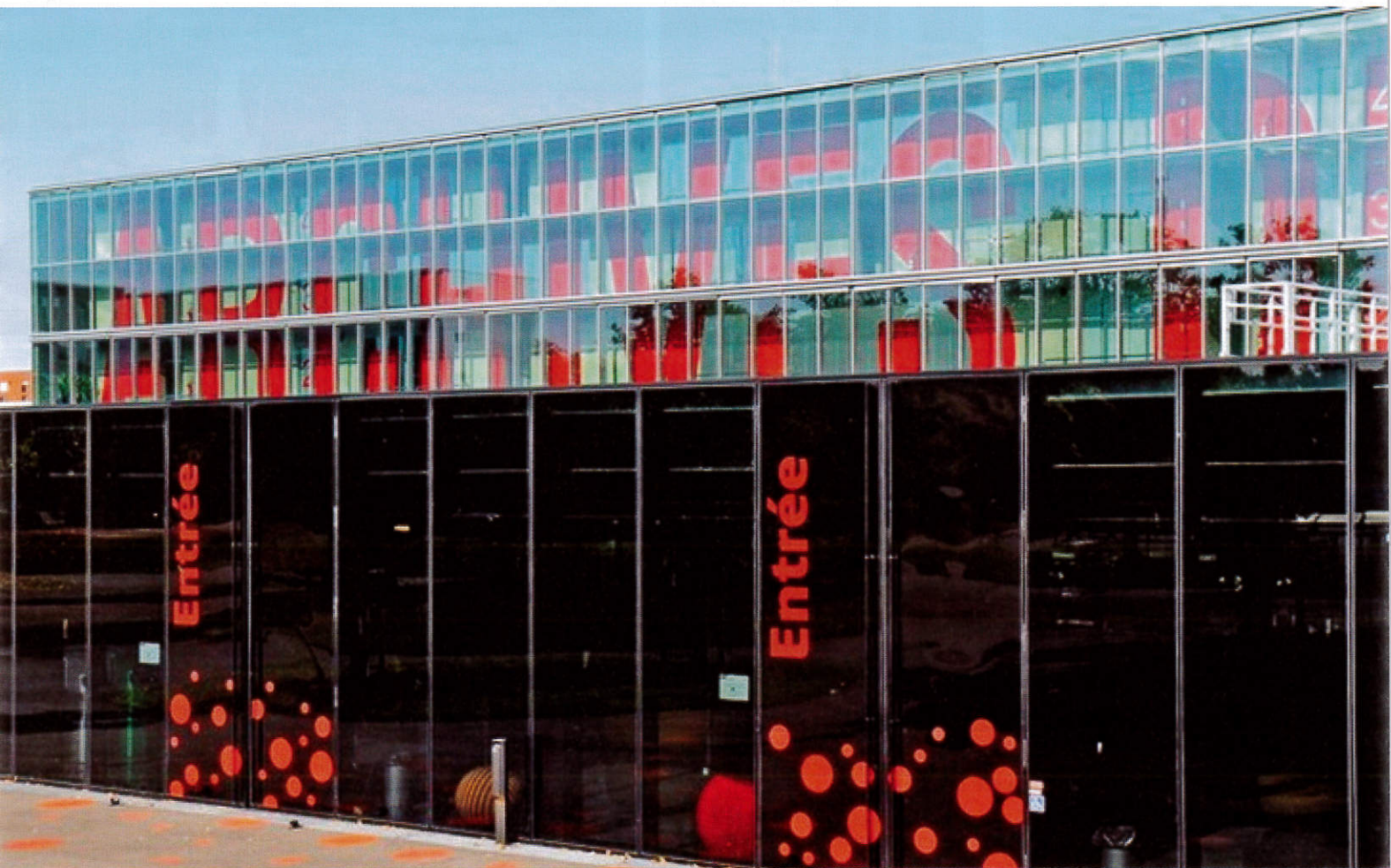
Le nouveau bâtiment des Archives départementales d'Ille-et-Vilaine, inauguré en juin 2017
